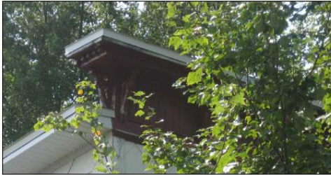
PARAPET À CONSOLES
